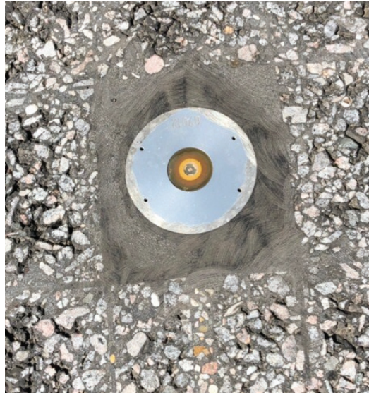
Рис. 4. Датчик ARCTIS в покрытии
