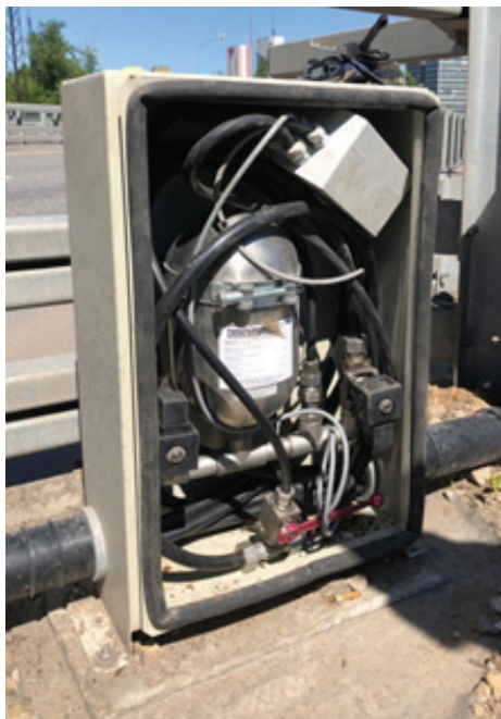
Рис. 10. Клапанная панель в защитном шкафу
