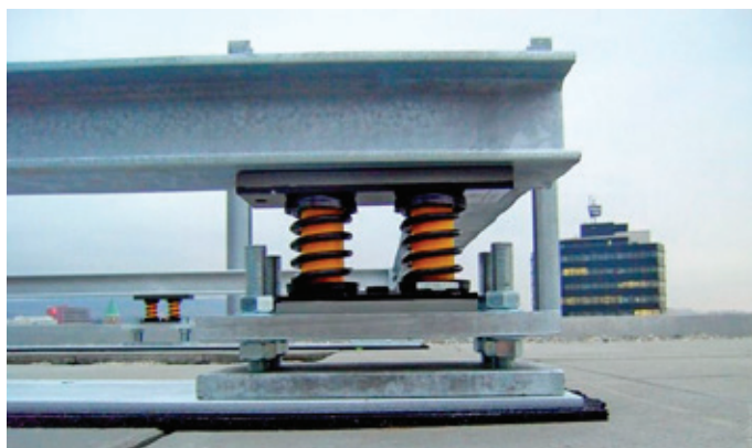
Рис. 2. Пружинный демпфер
