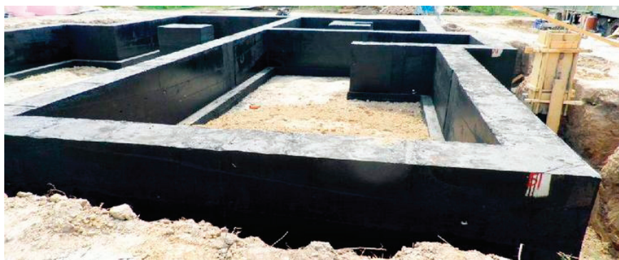
Рис. 1. Гидроизоляция ленточного фундамента
