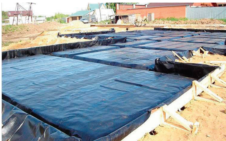
Рис. 2. Гидроизоляция плитного фундамента
