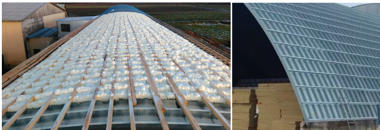
Рис. 5. Свод с закрепленными верхними полками
