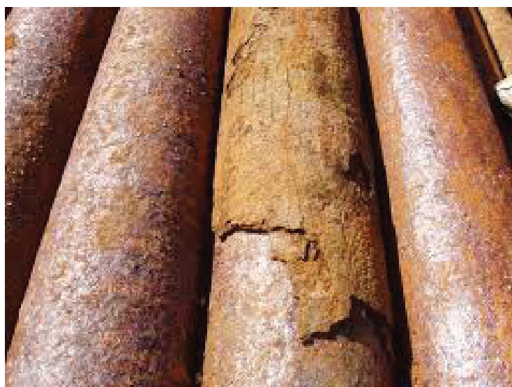
Рис. 3. Коррозия обсадной колонны
