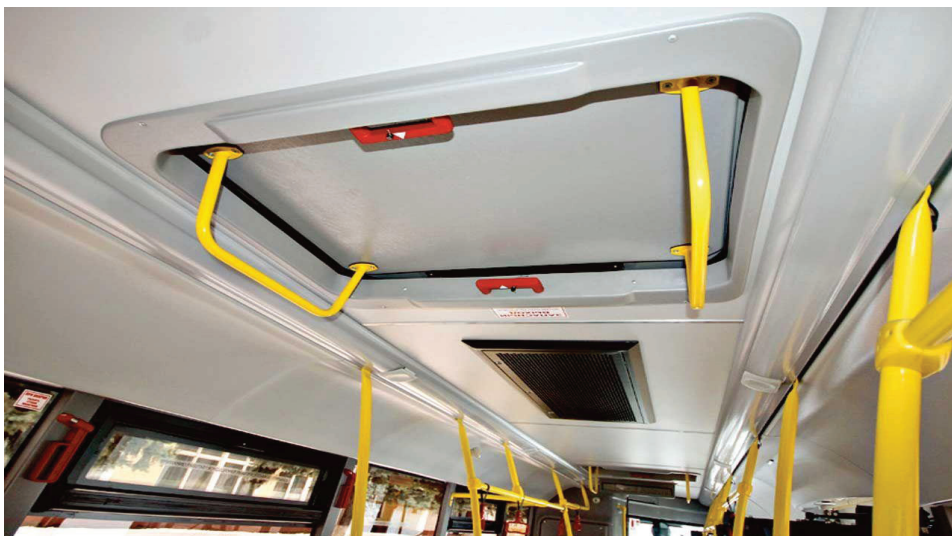
Рис. 4. Запасной выход в крыше автобуса
