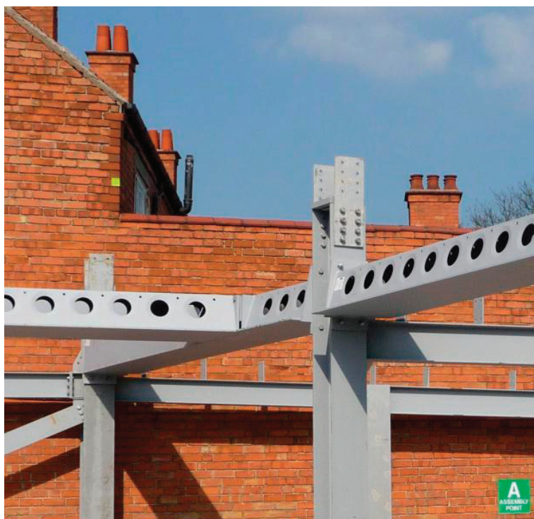
Рис. 5. Стальные каркасные надстройки с системой тонких перекрытий
