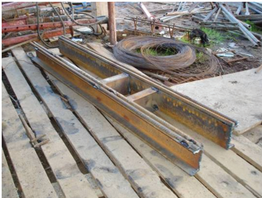
Рис. 4. Закладная деталь (по Л.Л. Кукше)
