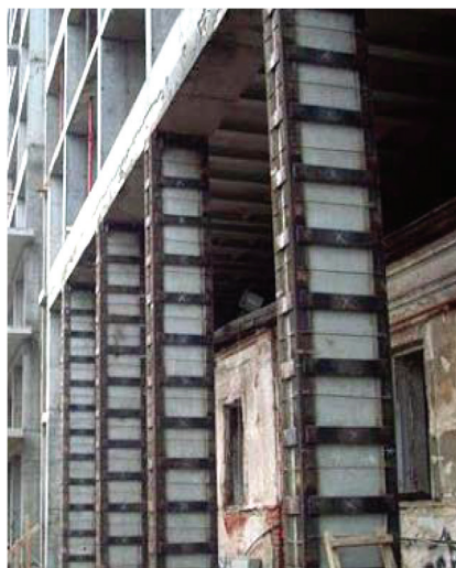
Рис. 4. Усиление железобетонных колонн стальными обоймами
