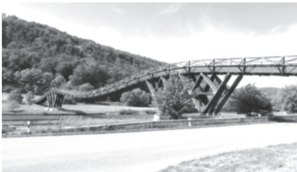
Рис. 9. Пешеходный мост в Эссинге
