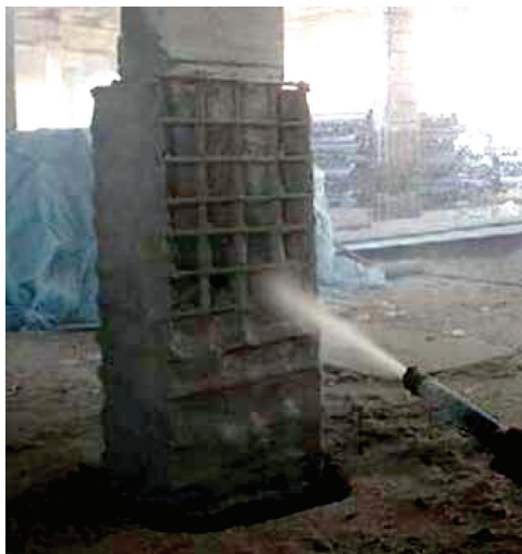
Рис. 3. Усиление железобетонной колонны с помощью железобетонной облоймы
