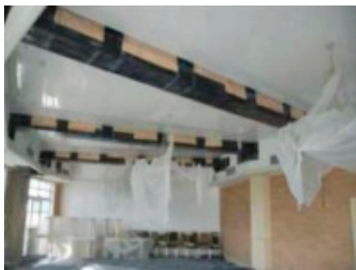
Рис. 2. Усиление деревянной балки перекрытия полимерными композитами в здании гольф-клуба, Болгария [6]
