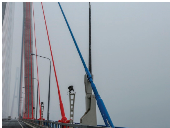
Рис. 1. Внешний демпфер на Русском мосту (г. Владивосток)
