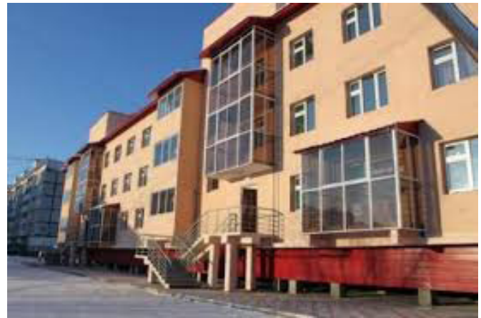
Рис. 1. Здания на Ямале. Здание с проветриваемым подпольем
