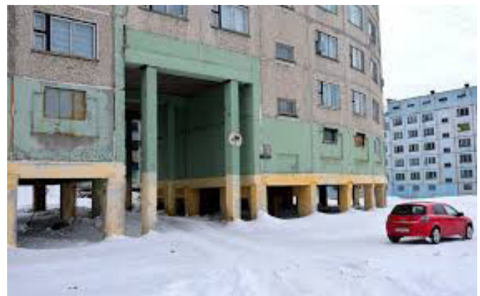
Рис. 2. Норильск. Здание с проветриваемым подпольем
