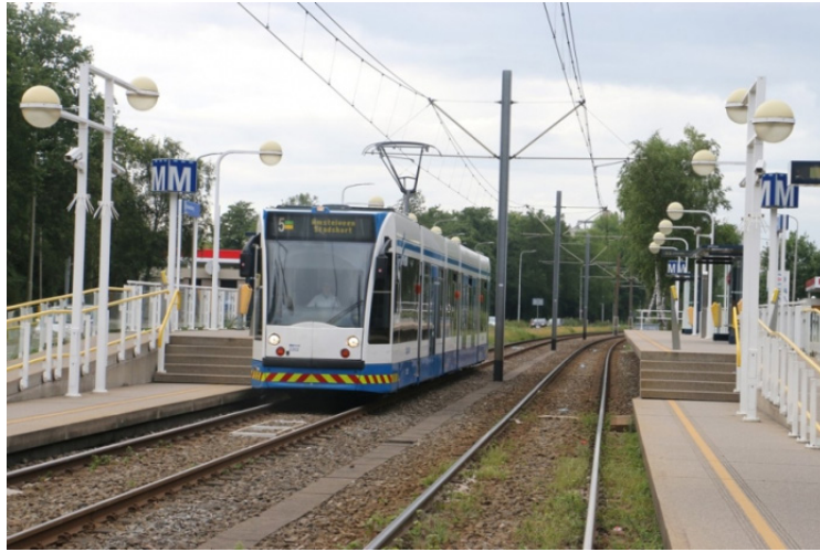
Рис. 4. Амстердам, сочетание высокой и низкой платформ [9]
