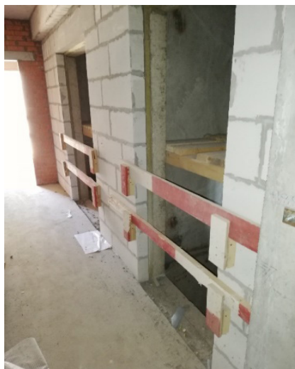
Рис. 5. Проем в шахту лифтов
