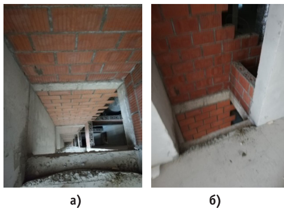
Рис. 4. Техническое отверстие в полу: а) вид сбоку; б) вид сверху
