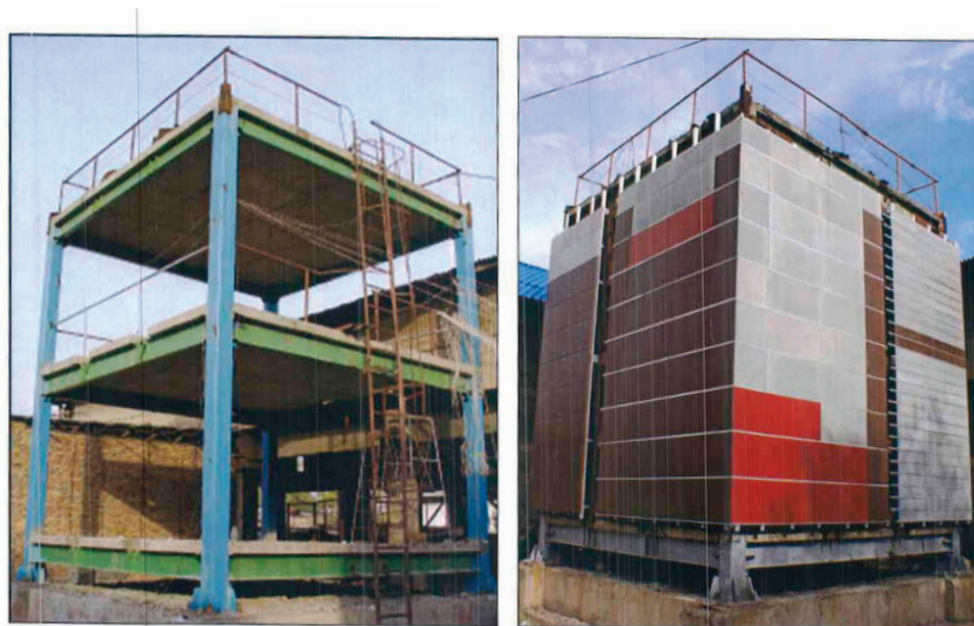
Рис. 1. Общий вид стенда до и после установки навесных фасадных систем
