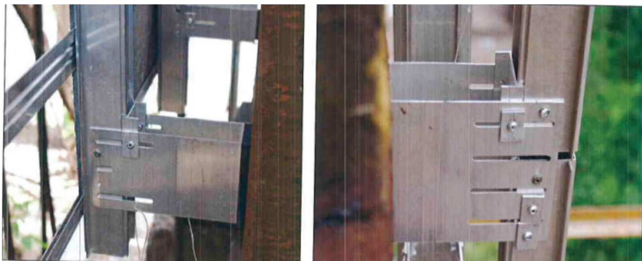
Рис. 5. Аллюминиевые подконструкции навесной фасадной системы
