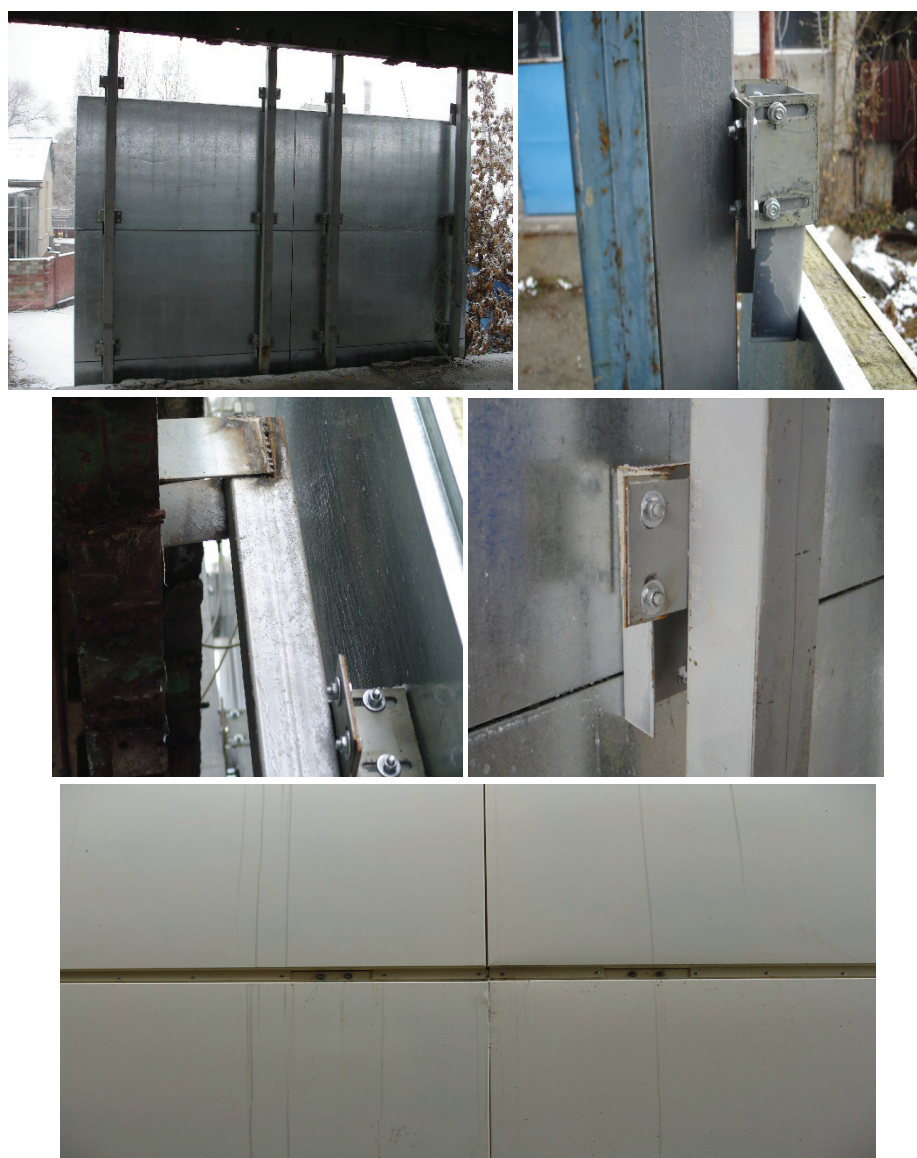
Рис. 2. Конструктивные решения крепления сэндвич панелей
