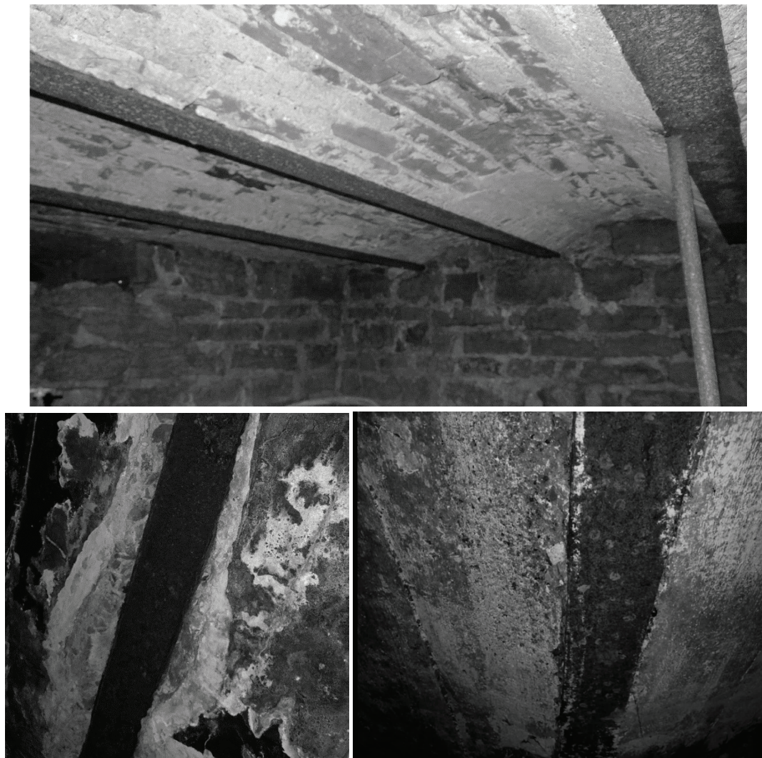
Рис. 1. Перекрытия в виде кирпичных сводов по металлическим балкам на различных объектах культурного наследия: сверху — «Красный дом», г. Ивангород; слева — «Дворец культуры», г. Выборг; справа — Учебный корпус СПб ГМТУ
