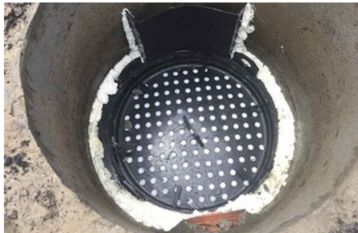
Рис. 3. Фильтрующий патрон, установленный в железобетонный колодец
