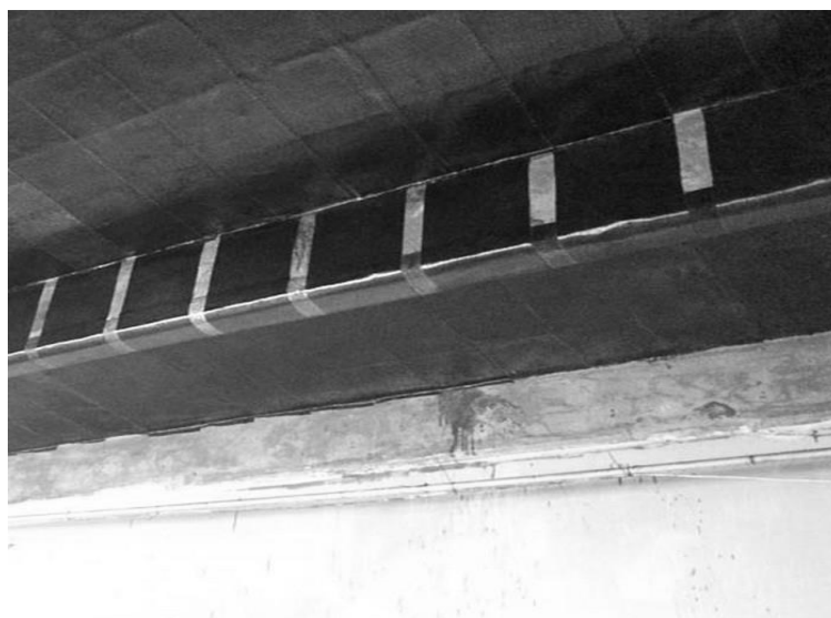
Рис. 2. Усиленное композитными материалами монолитное перекрытие
