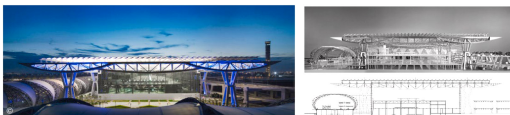
Рис. 1. Пассажирский терминал комплекс Аэропорт Суварнабхуми, Тайланд, Бангкок
