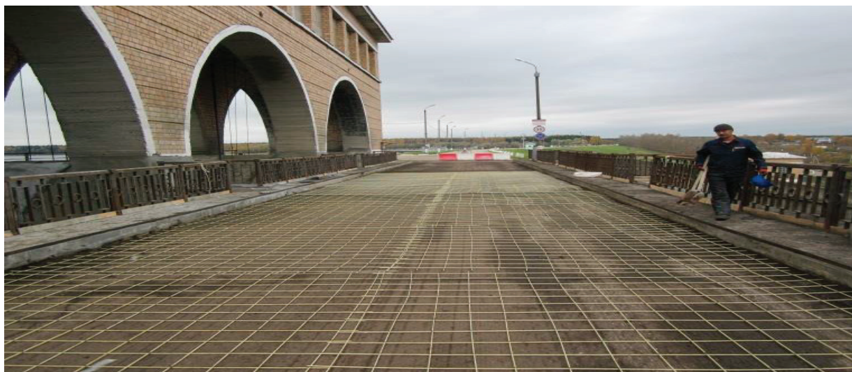
Рис. 2. Усиление дорожного полотна подъезда к мостовому переходу над поверхностным водосбросом Можайской плотины МГТУ
