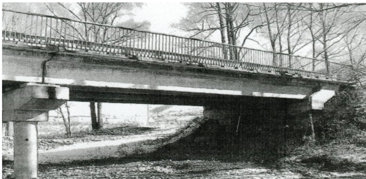
Рис. 3. Мост возведенный с применением композитной арматуры в Еврейской автономной области в 1989 г.
