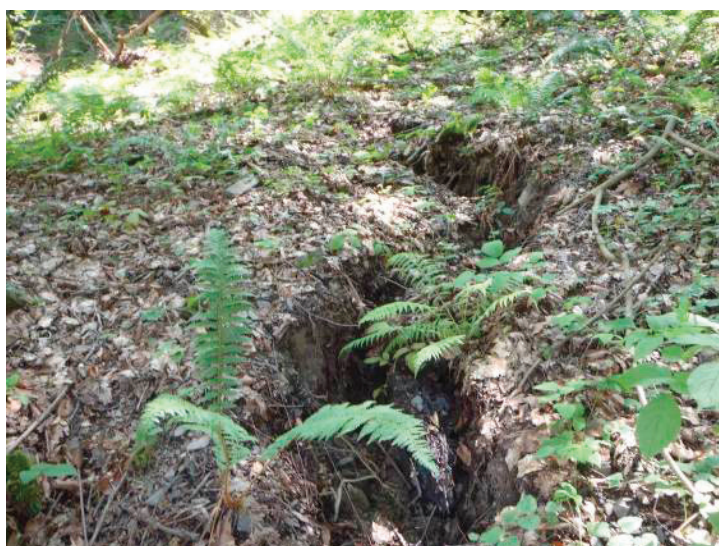
Рис. 3. Склон подвержен эрозионным процессам
