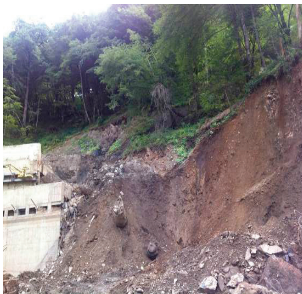
Рис. 1. Склон подвержен эрозионным процессам
