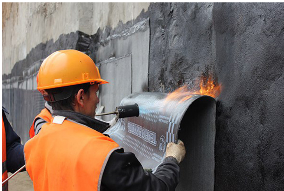
Рис. 1. Оклеечная гидроизоляция [2]
