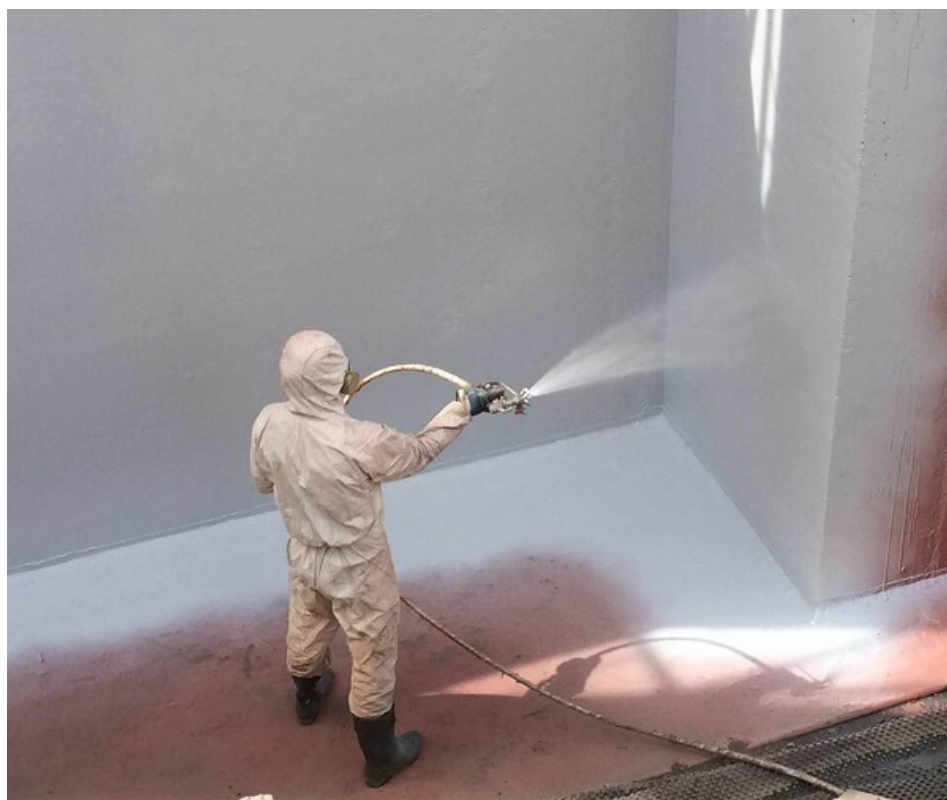
Рис. 2. Окрасочная гидроизоляция [3]
