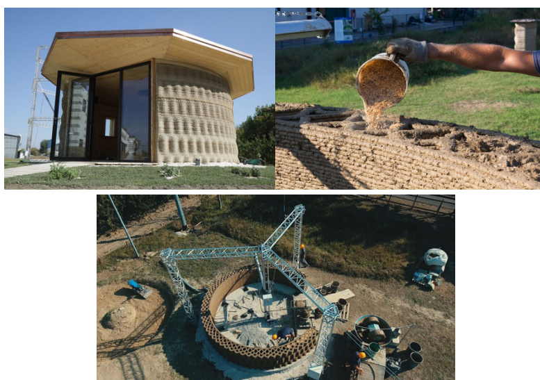
Рис. 4. 3D-печатный дом Gaia. Масса Ломбардо, Италия
