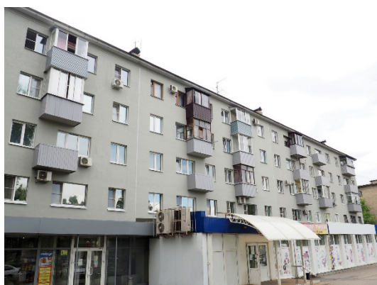
Рис. 4. «Хрущевка» в г. Воронеж после ремонта (Источник: https://fkr36.ru/fotootchet-o-hode-kapitalnogo-remonta-mnogokvartirnyh-domov-v-g-voronezhe )
