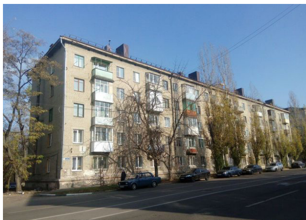
Рис. 2. Дом в г. Воронеж на ул. Менделеева, постройка 1959 года
