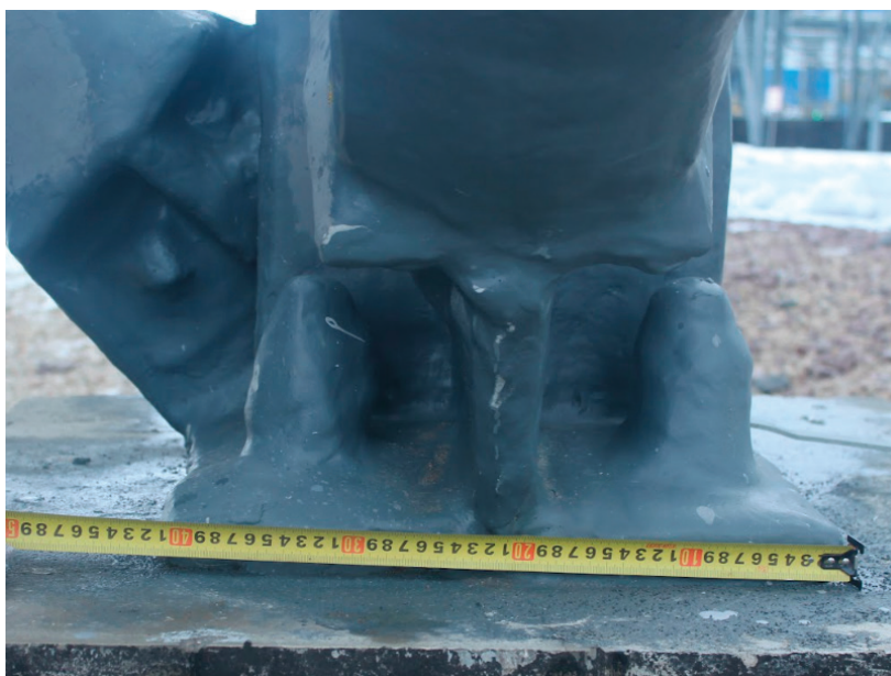
Рис. 1. Выполненная огнезащита металлических конструкций
