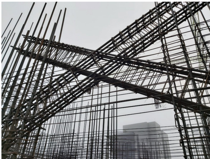
Рис. 5. Общий вид выполненной связующей балки (перемычки), соответствующие пункту 5.4(4)
