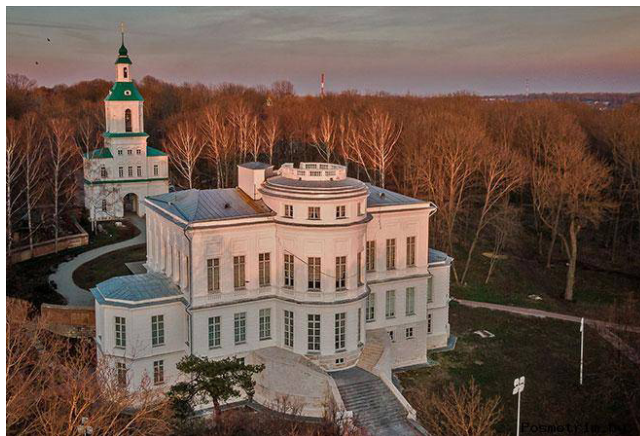
Рис. 6. Дворец и башня. Современный вид
