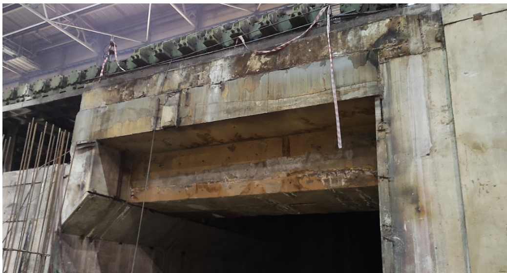
Рис. 1. Железобетонные конструкции на металлургическом предприятии
