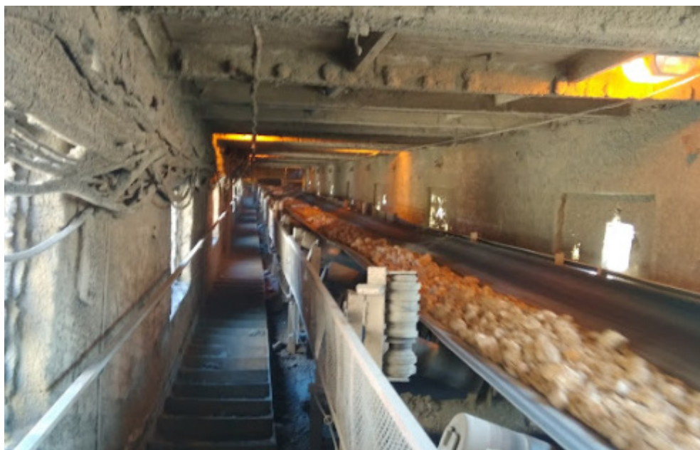
Рис. 2. Железобетонные конструкции галере на предприятии по производству цемента
