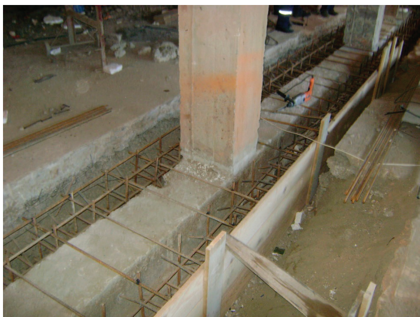
Рис. 1. Усиление ленточного фундамента железобетонными обоймами
