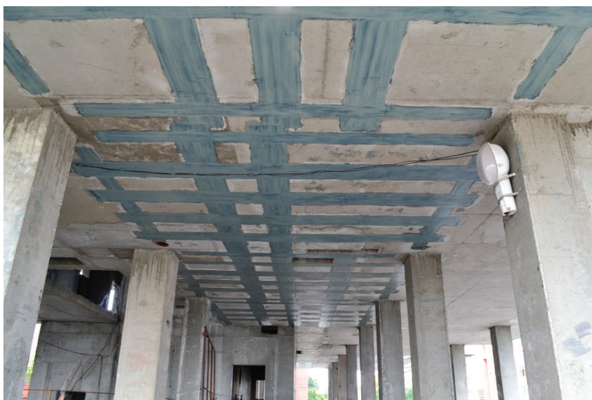
Рис. 2. Усиление плит перекрытия углеволокном
