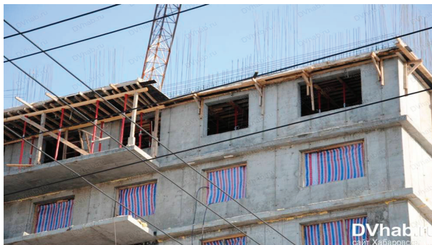
Рис. 2. Использование бруса на телескопических стойках в качестве балок опалубки перекрытия на объекте ЖД Беринг г. Хабаровск
