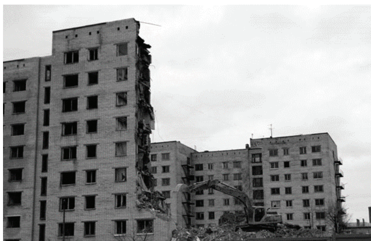
Рис. 7. Трагедия на ул. Двинской в Санкт-Петербурге. Обрушение общежития
