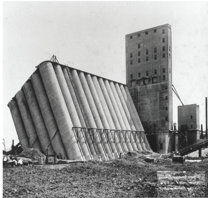
Рис. 1. Падение Трансконского элеватора, Канада
