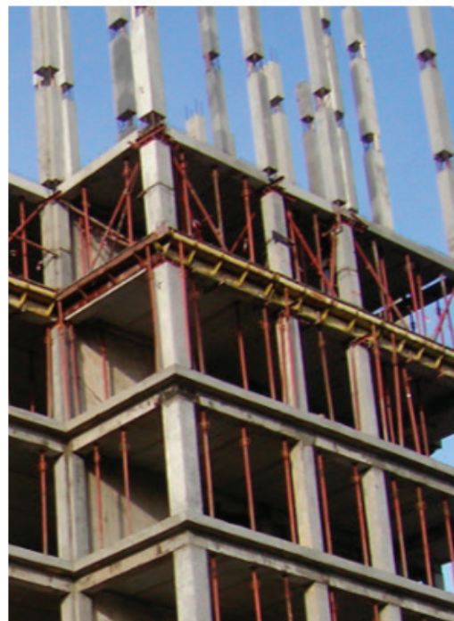
Рис. 4. Узел стыковки сборно-монолитных элементов по рабочему проекту
