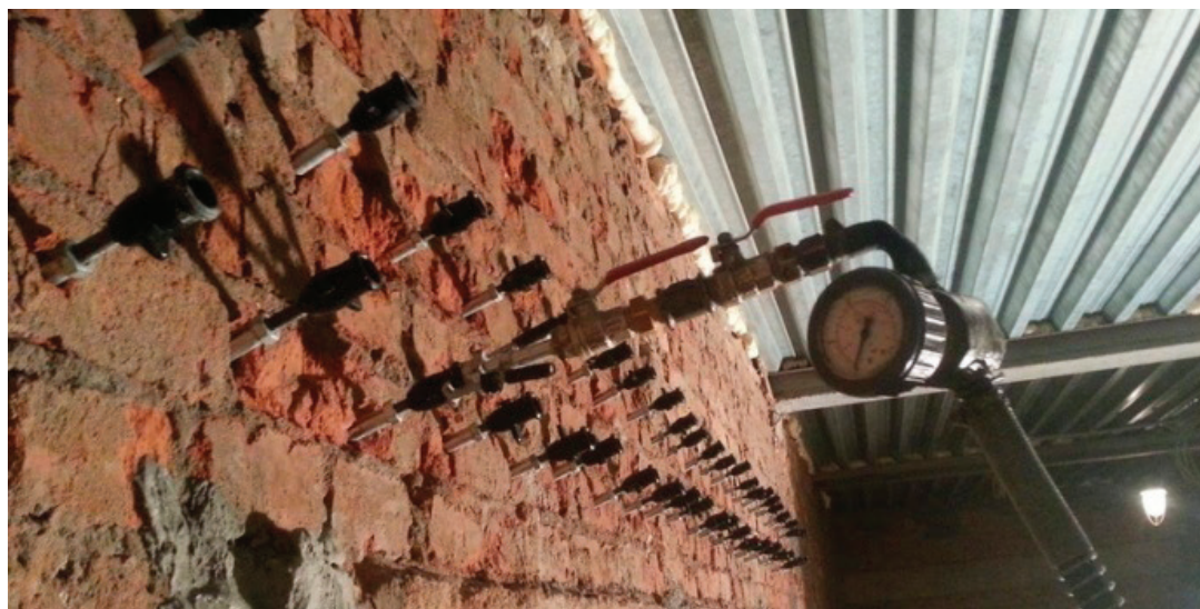
Рис. 5. Нагнетание раствора в кладку через предварительно установленные пакеры
