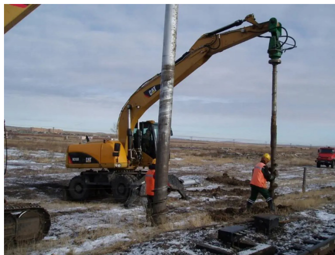
Рис. 5. Погружение винтовых свай в вечномёрзлый грунт
