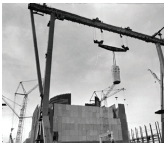
Рис. 4. Строительство Балаковской АЭС методом «open-top»
