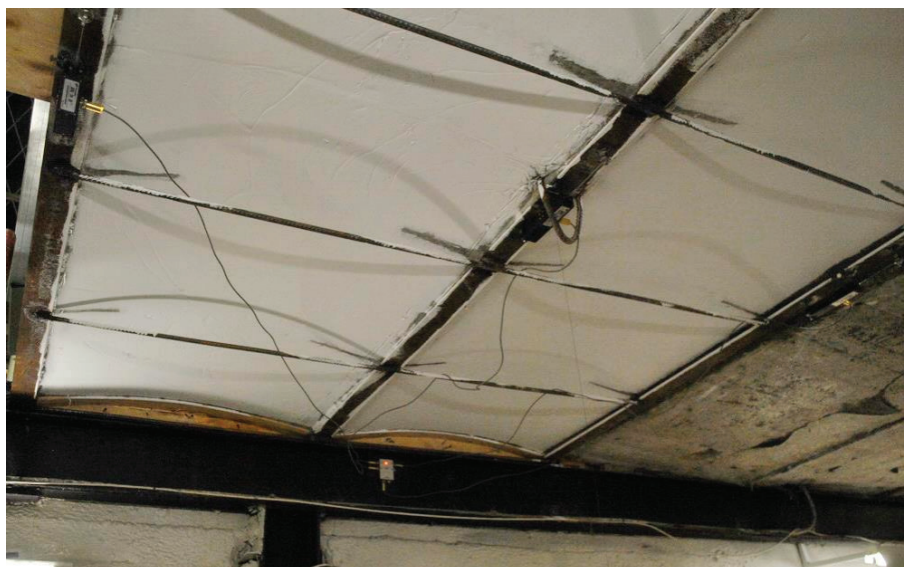
Рис. 9. Вид на перекрытие снизу
