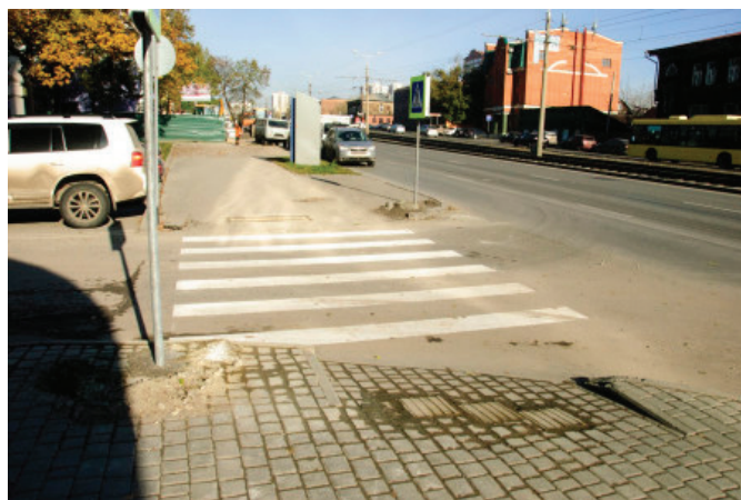
Рис. 2. Пешеходный переход с нарушением устройства тактильной плитки
