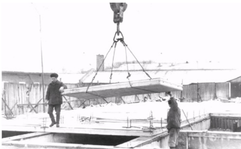
Рис. 4. Монтаж панелей перекрытия строительной системы «Модуль»
