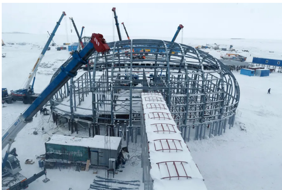
Рис. 3. Монтаж каркаса здания из стальных оцинкованных профилей (работы ведет Спецстрой России)
