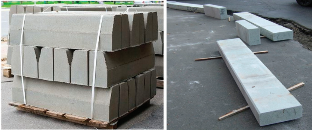
Рис. 1. Бортовой камень. В зависимости от того, как он устанавливается — заподлицо или с вертикальным выступом — ребром, носит наименование бордюра или поребрика
