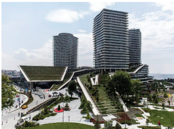
Рис. 2. Зеленая кровля ТРЦ Zorlu в Турции
