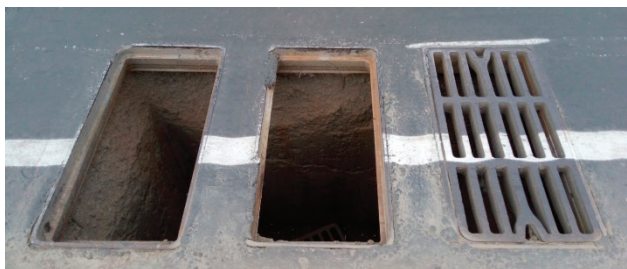
Рис. 1. Чугунные дождеприёмники
