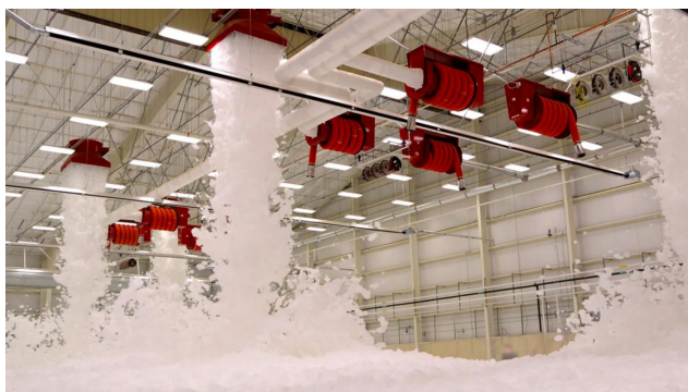
Рис. 3. Система автоматического пенного тушения
