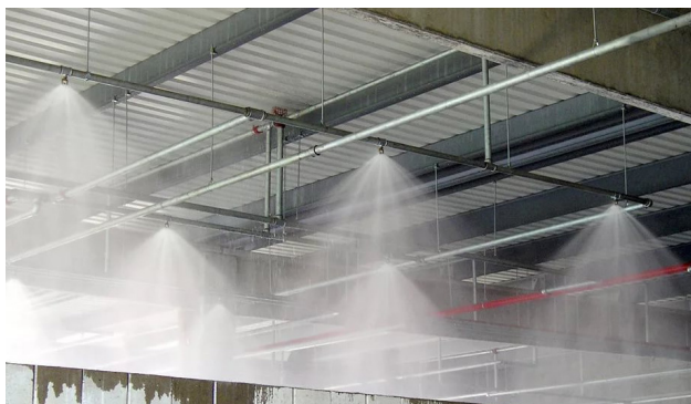
Рис. 2. Дренчерная система автоматического пенного тушения
