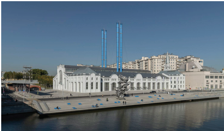
Рис. 8. Общий вид на ансамбль ГЭС-2.
