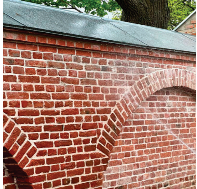
Рис. 7. Промывка кирпичной кладки водой после проведения бицидной обработки Федоровский городок, город Пушкин, 2021 г.
