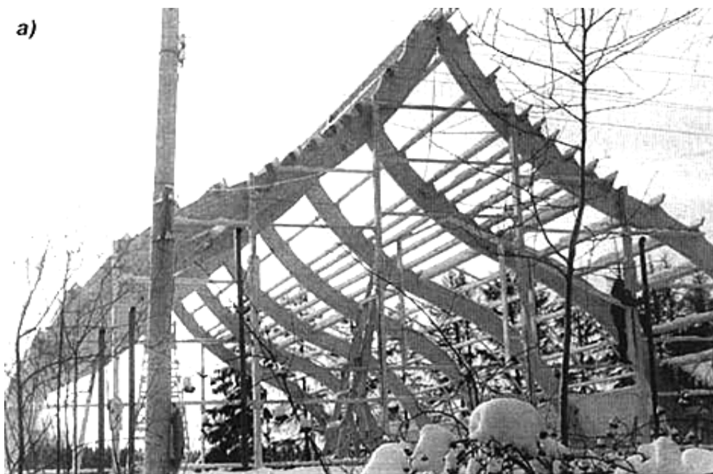
Рис. 5а. Арочные конструкции теннисного корта в п.Снегири Московской области. Пролёт 18 м.
