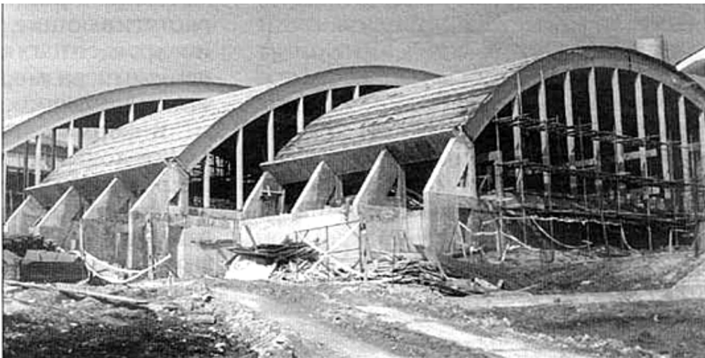
Рис. 3. Конструкции спортивного комплекса «Буран». Пролеты 24, 29, 34 м
