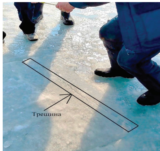
Рис. 4. Трещина, образовавшаяся в результате испытаний
