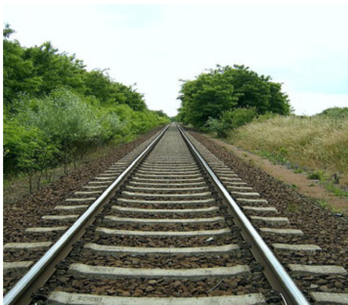
Рис. 1. Железнодорожный путь с железобетонными шпалами
