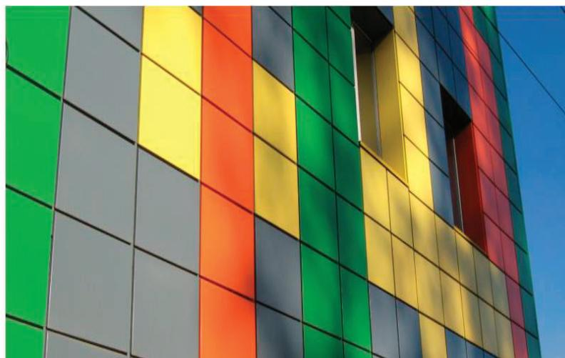
Рис. 7. Система с облицовкой из металлокассет
