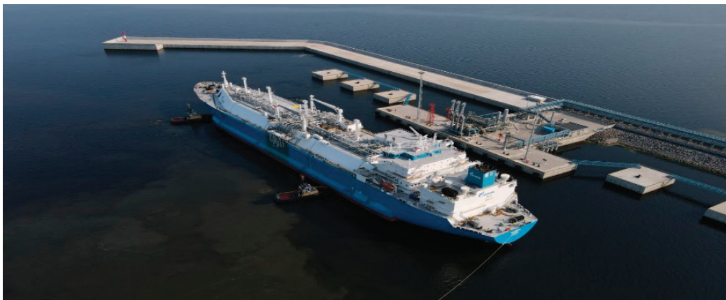
Рис. 4. Резервуар хранения СПГ [4]
