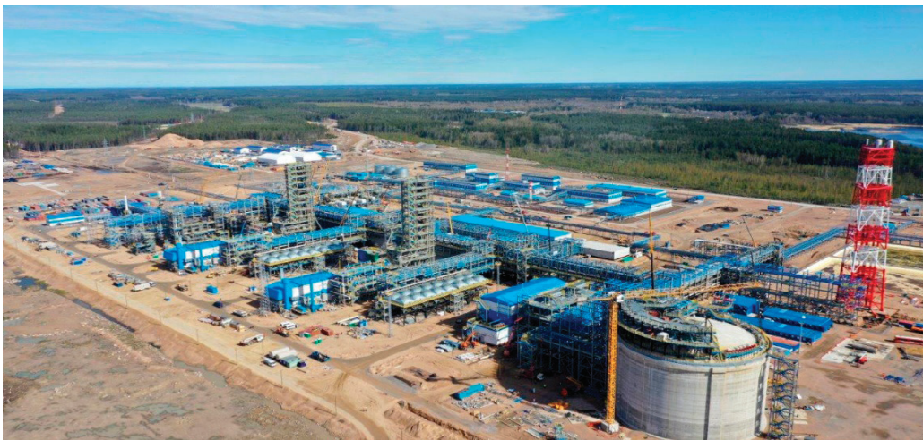
Рис. 3. Резервуар хранения СПГ [3]
