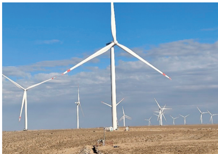
Рис. 4. Зарафшанская ВЭС мощностью 500 МВт, Навоийская область, Узбекистан
