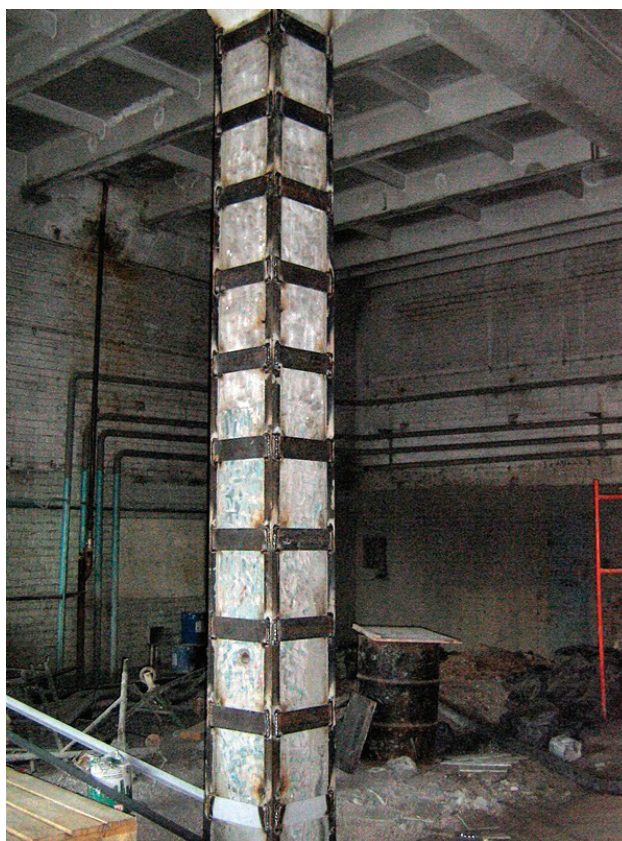
Рис. 2. Усиление колонны стальной обоймой
