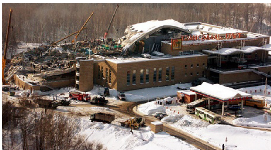
Рис. 1. Обрушение Трансваль-Парка г. Москва
